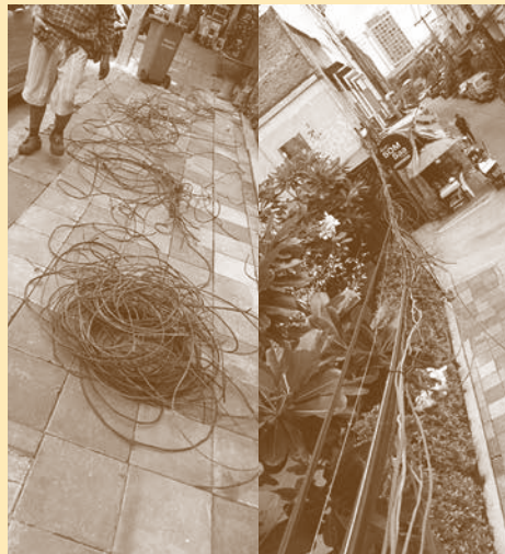
การดำเนินการรื้อย้ายสายโทรศัพท์ที่ไม่ได้ใช้งาน และจัดระเบียบสายเคเบิลอินเทอร์เน็ต
